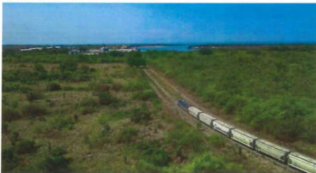
Figura 18 Línea KA del ferrocarril de (CIIT) que conecta a Puerto Chiapas. Fuente: ASIPONA Puerto Chiapas, 2024.
