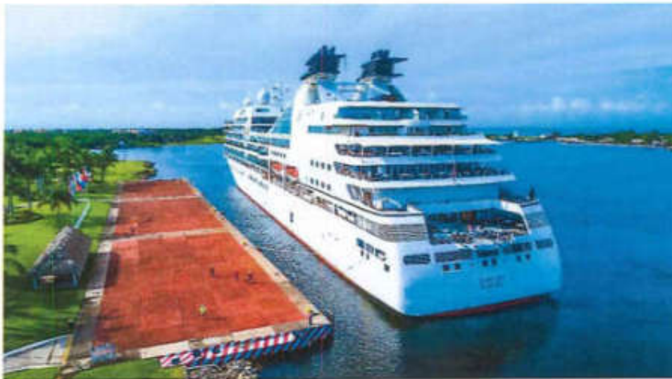
Figura 6 Muelle de cruceros. Fuente: ASIPONA Puerto Chiapas, 2024.
