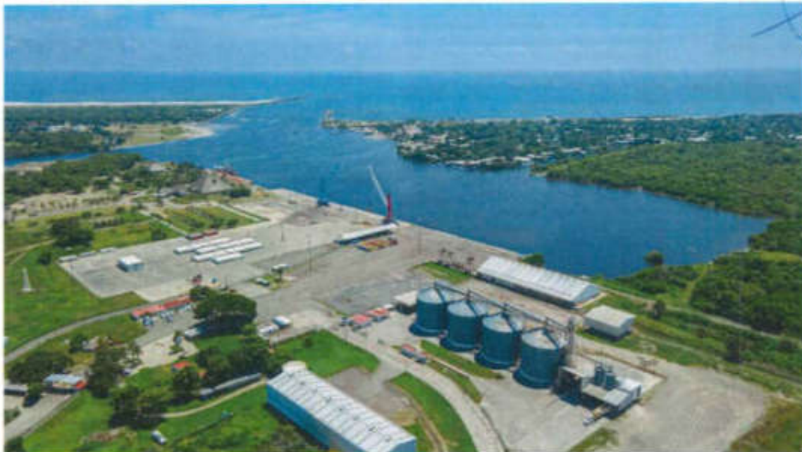
Figura 11 Área de Cesionarios, TUM, Terminal de contenedores y de cruceros de Puerto Chiapas.
