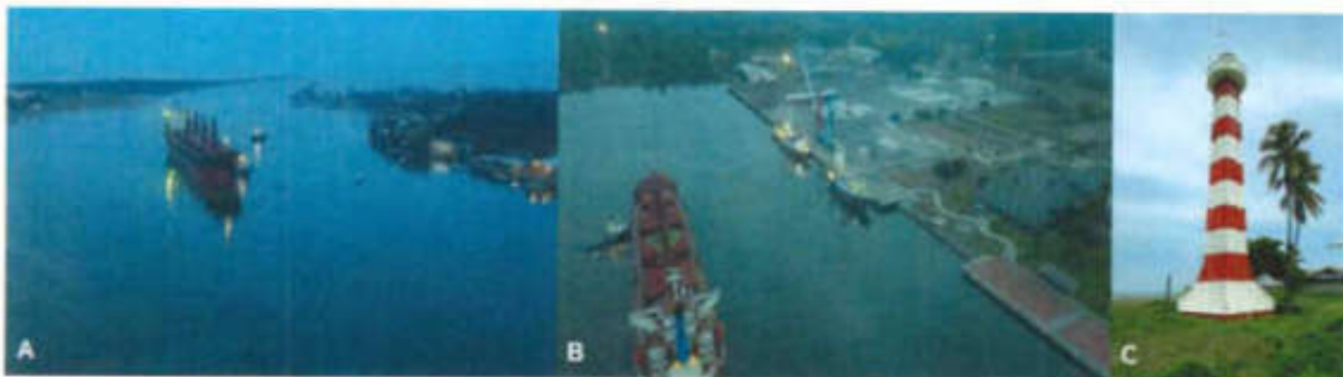
Figura 3 Señalamiento marítimo de Puerto Chiapas: Fig. A y B, señalamiento en funcionamiento en maniobras y; C Faro de San Benito, Puerto Madero, Chis.
